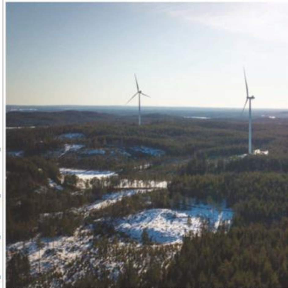
De 16 vindkraftverken står utpräglade i skogen och når långt över trädkropparna. Stora delar från dem hörs redan när det är svag vind och rotorbladen
